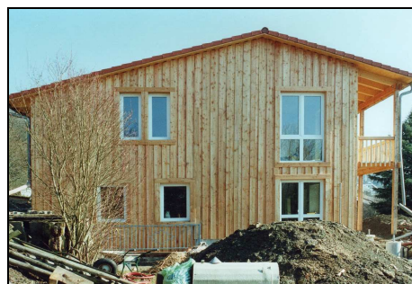
Abb.: Foto während der Baustelle
