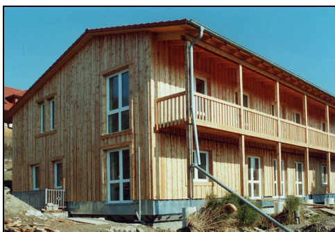
Abb.: Foto während der Baustelle
