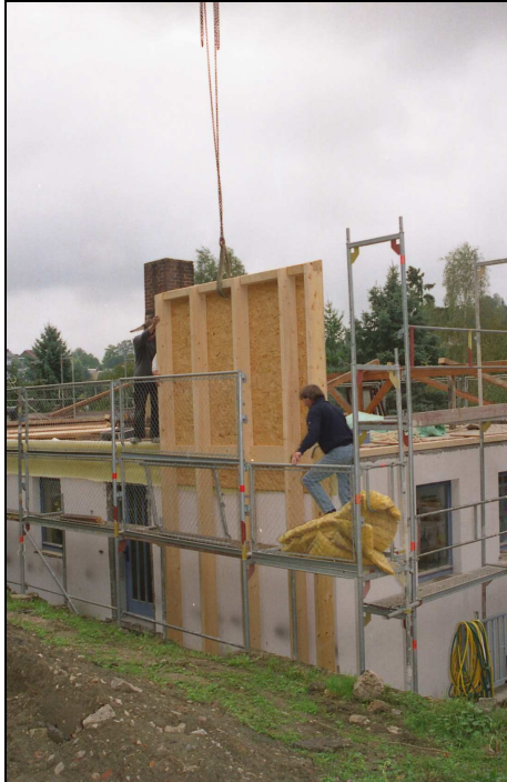
Abb.: Foto Aufrichten der Holzkonstruktion
